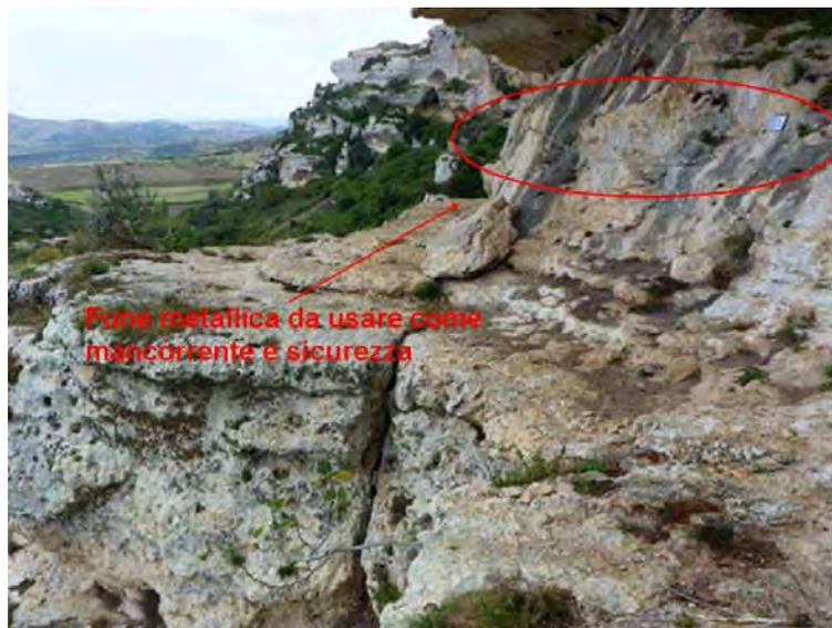
Il blocco a rischio frana e la modifica attuata per metterlo in sicurezza: una fune metallica per ancorarsi durante il passaggio sopra
