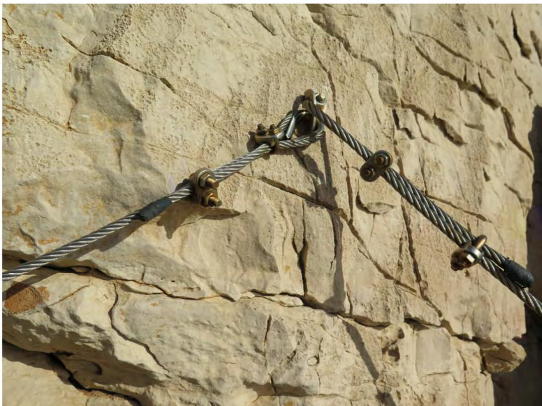
Inizio e fine tratta di fune su un solo ancoraggio da 10 mm con numero insufficiente di morsetti di serraggio. I morsetti sono applicati rovesci ed a distanza eccessiva. Non è presente su una fune la redancia.
