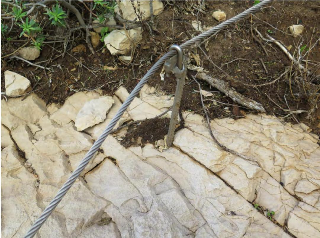
Ancoraggio inserito nel piano di separazione tra due strati di sedimentazione che determina una scarsa resistenza. Inoltre data la sporgenza eccessiva dovrebbe essere controventato
