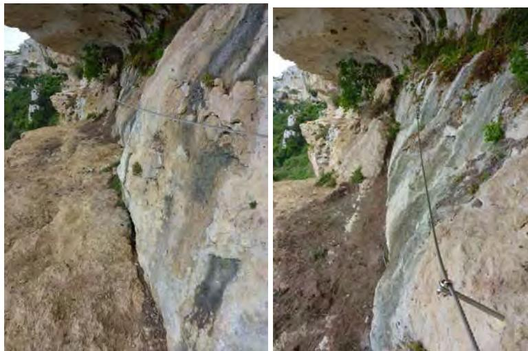
Fune metallica e ancoraggi per il passaggio sopra il blocco
