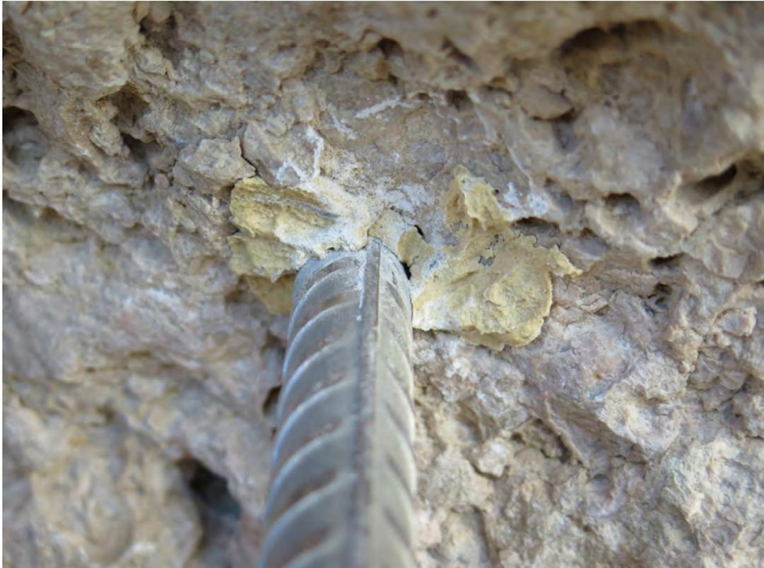
Ancoraggio resinato male con la barra di acciaio che si muove nel foro
