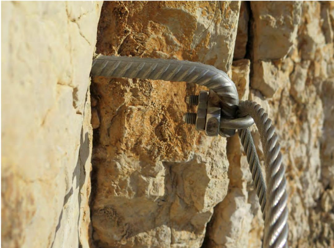
Ancoraggio non adatto alla situazione, la fune obliqua in uscita genera un momento torcente/flettente sulla barra resinata. La barra di acciaio si muove nel foro
