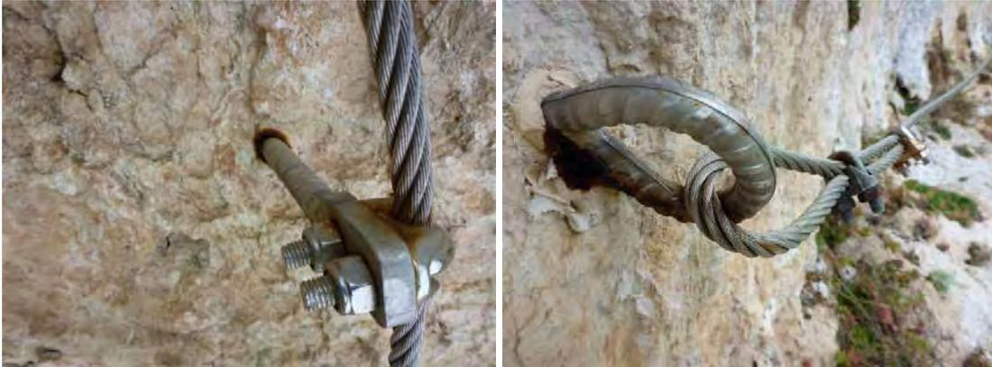
Alcuni distanziatori e ancoraggi arrugginiti alla base a causa di percolazione d'acqua penetrata nel cemento chimico
