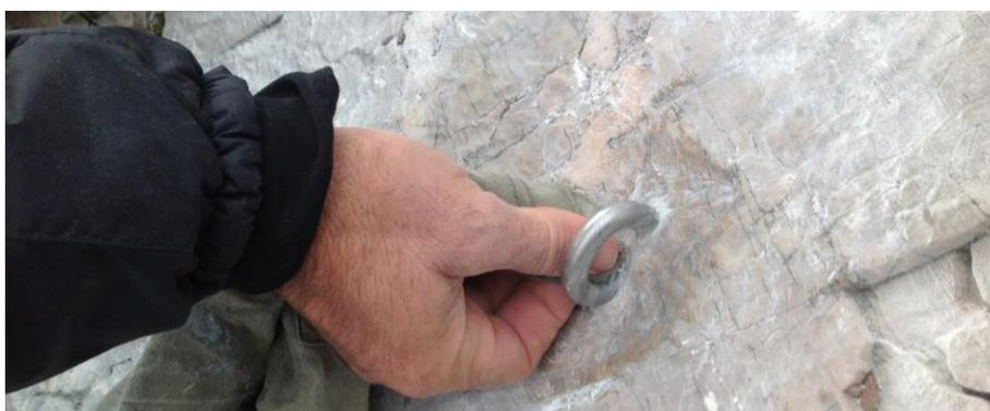
Si ricorda che è importantissimo è incassare parte dell'occhiello nella roccia "affogandolo" con la resina. Questo accorgimento fin d'ora quasi mai attuato (anche le case costruttrici non lo specificano nei manuali di installazione dei chiodi resinati) diminuisce cattive leve di estrazione e di rotazione causate dal rinvio in tensione durante la "moulinette" specialmente nel caso di vie strapiombanti o diagonali.
